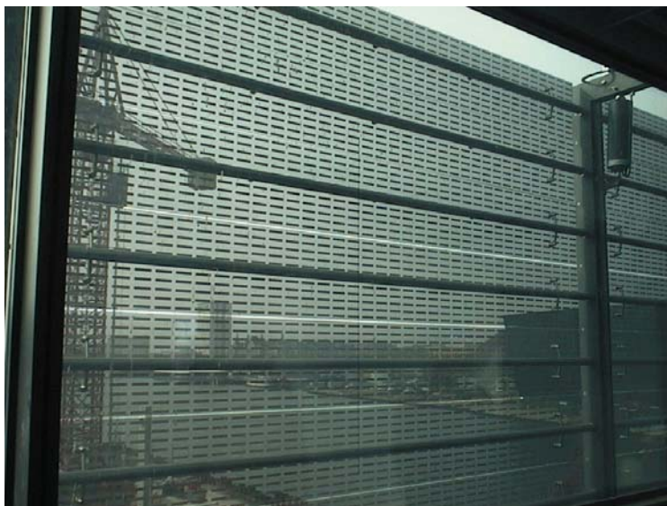
Figur 3.4: Den udvendige solafskærmning hvor glaslammellerne er helt lukkede.
