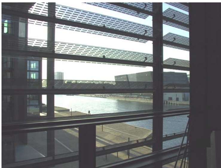
Figur 3.3: Den udvendige solafskærmning bestående af glaslameller med silketryk.
