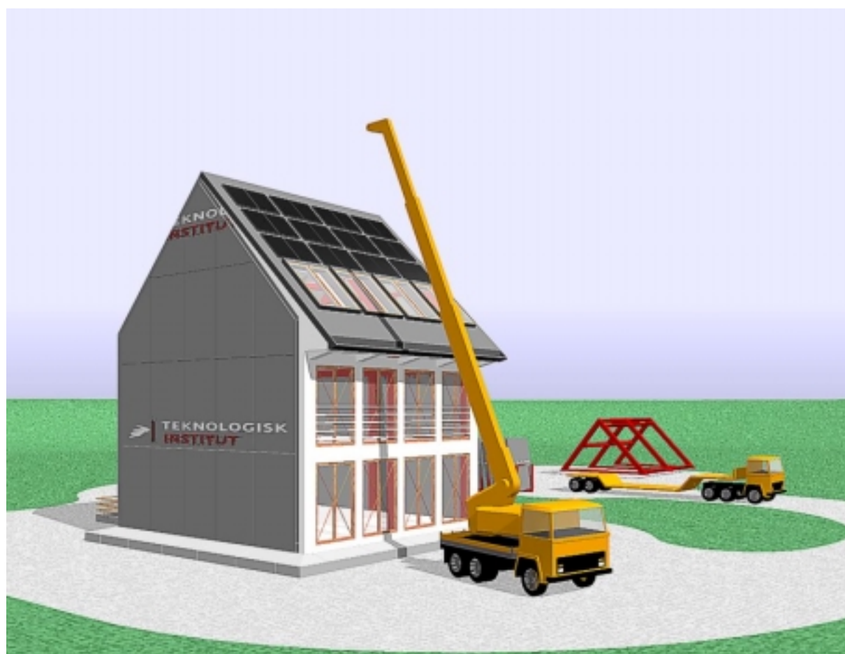
Figur 3.7. Installering af sydfacade og sydvendt tag.
