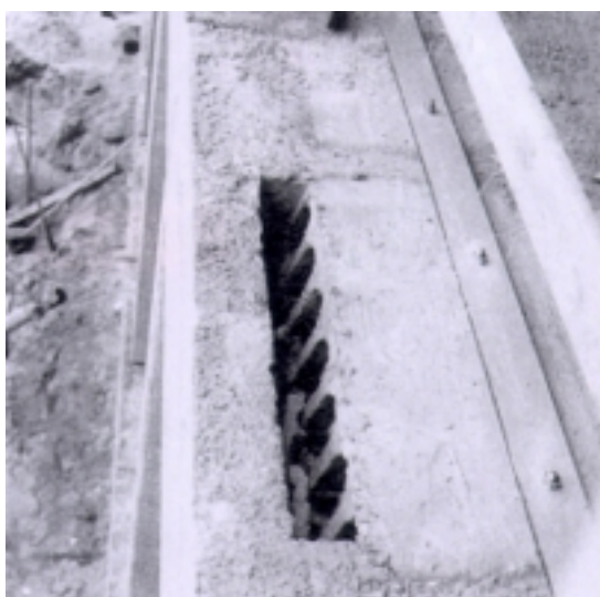
Figur 2.3. Overgangen fra betonhuldæk til indblæsningsskakt i det nye pædagogiske seminarium i Ikast (Lehrskov,1999).
