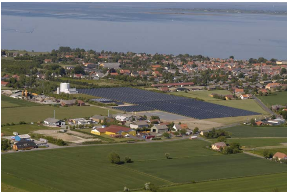
Figur 1.7. Solvarmeanlægget efter udvidelsen til 18.370 m 2 .
