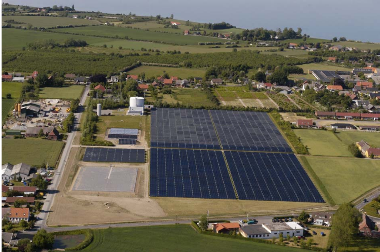
Figur 1.8. Solvarmeanlægget efter udvidelsen til 18.370 m 2 .
