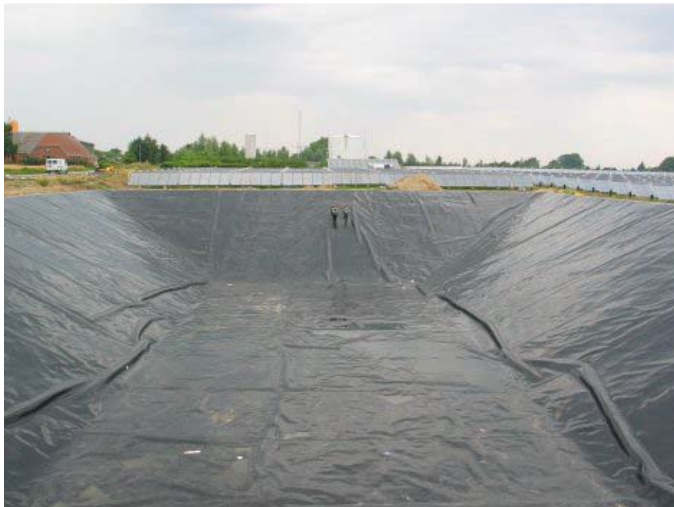
Figur 1.16. Damvarmelageret før ifyldning af vand.
