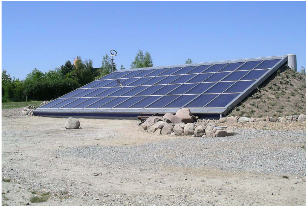
Figur 1.13. Tagintegrerede solfangere fra Wagner, Tyskland.
