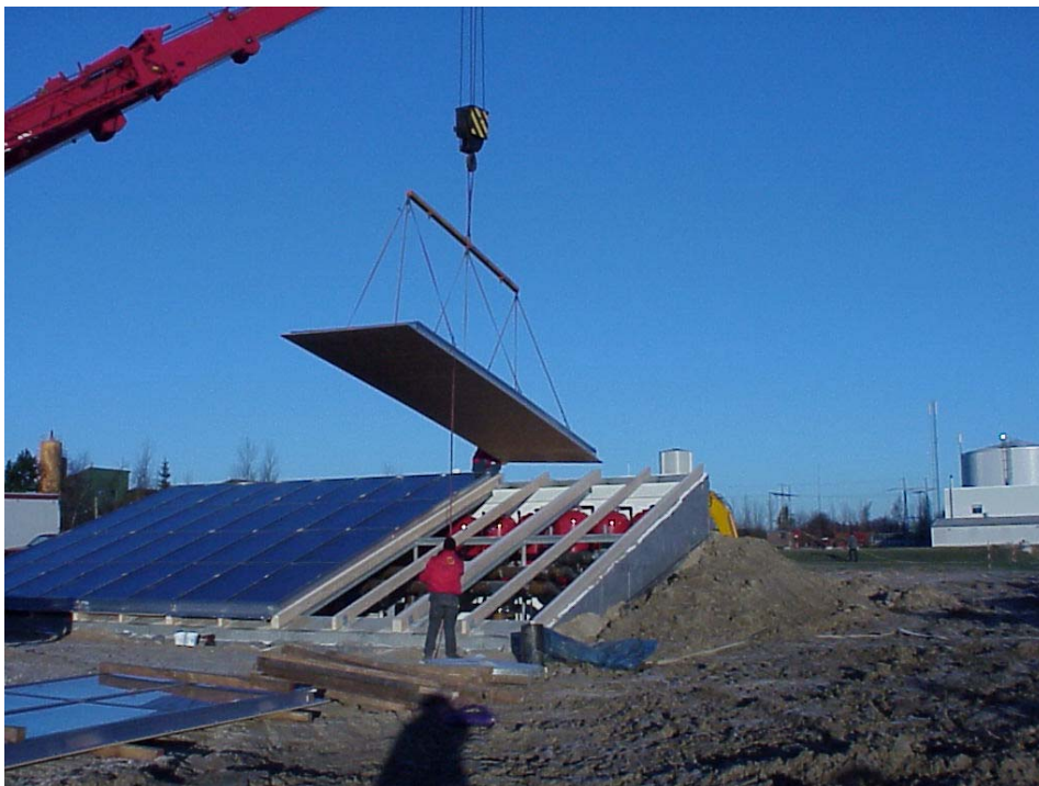
Figur 1.14. Montage af de tagintegrerede solfangere.
