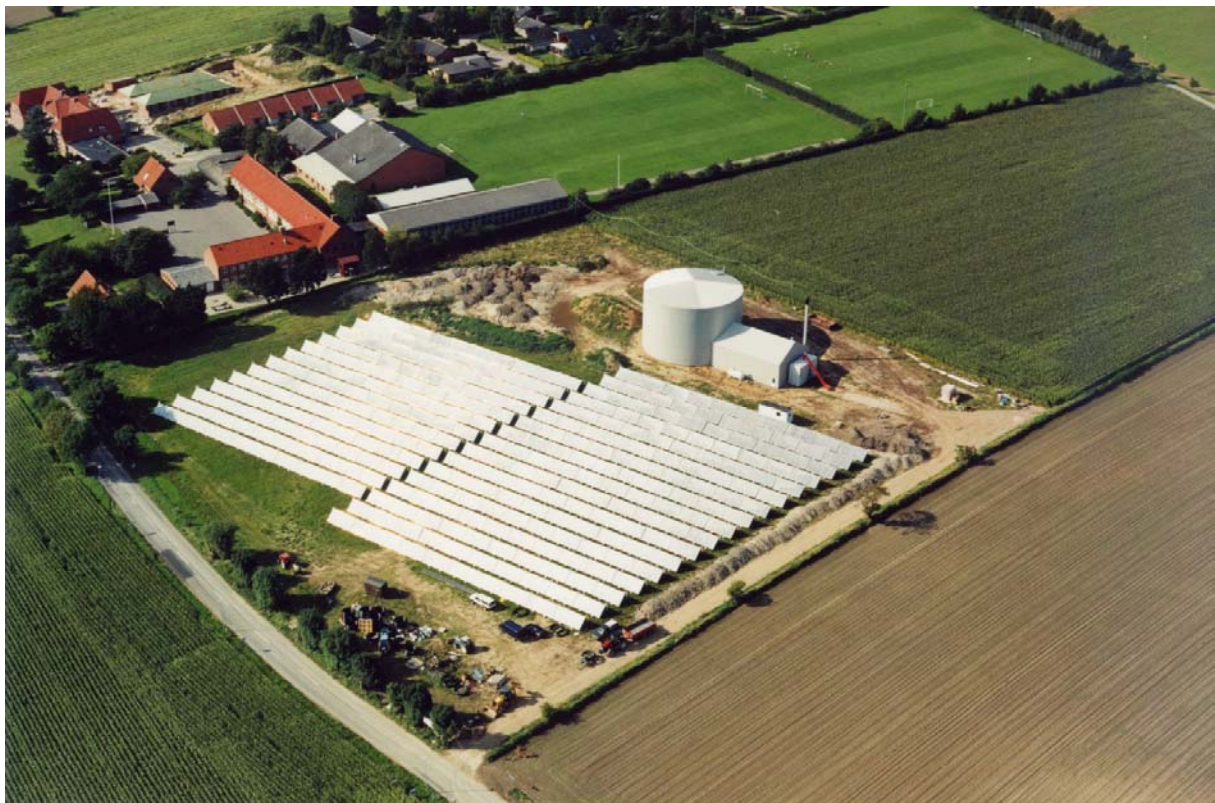
Figur 1.2. Rise Fjernvarme hvor akkumuleringstanken og kedelcentralen ses lige over solfangerfeltet.
