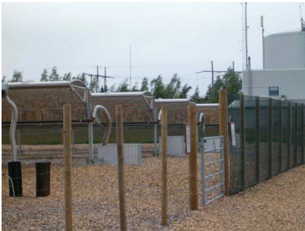
Figur 1.11. De fokuserende solfangerne fra IST, hvor truget er vendt på grund af for lille solindfald.
