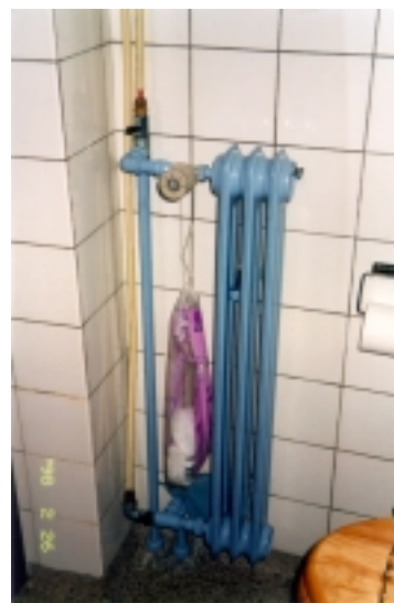
Figur 3.6. Koblingen mellem radiatoren og lagerets suppleringsvarmeveksler.
