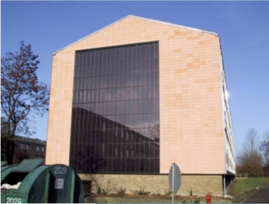
Sydgavl med solcelle-felt på 52 m 2
