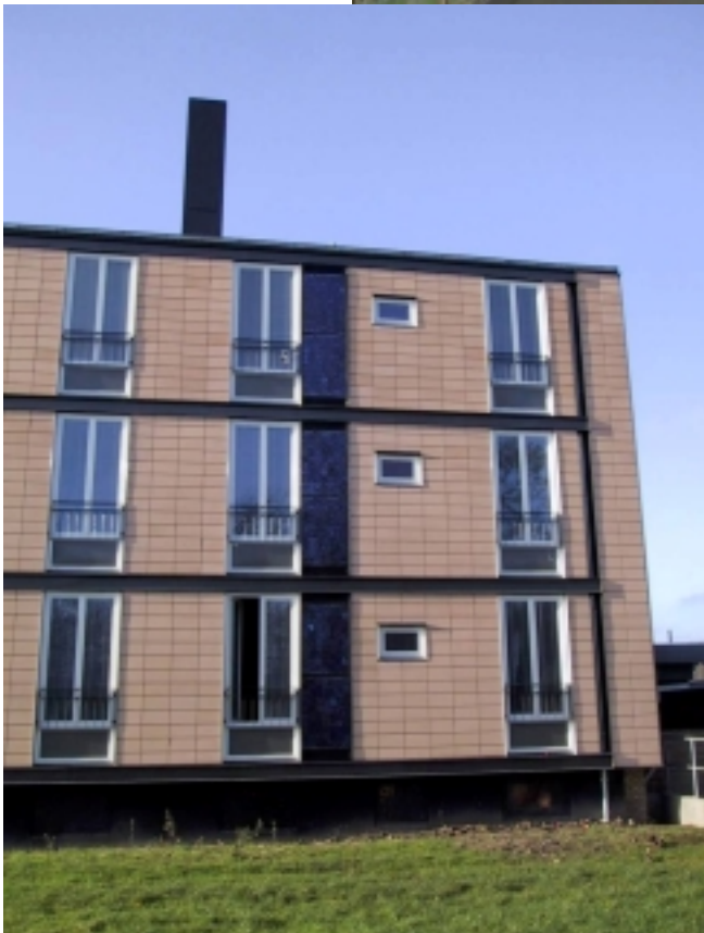
Solcelle-paneler i facaden til tre lejligheder
