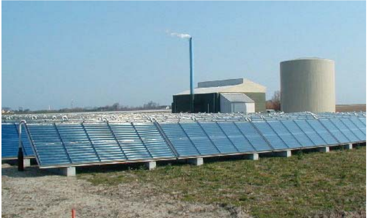
Figur 1.4. Solfangerfelt med lagerbeholder og kedelcentral i baggrunden
