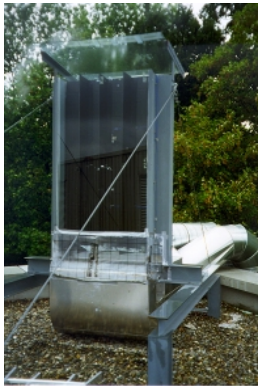
Figur 1.5. Billede af tag-unit med solskorsten.
