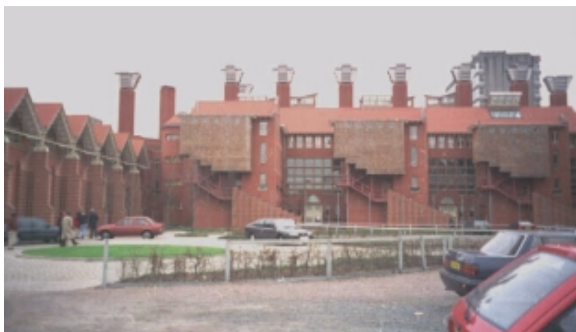
Figur 4.5. Ventilationstårne på Queens Building i Leicester, UK. Til højre er vist en skitse af princippet i afkastet (Architecture Today, 1991).
