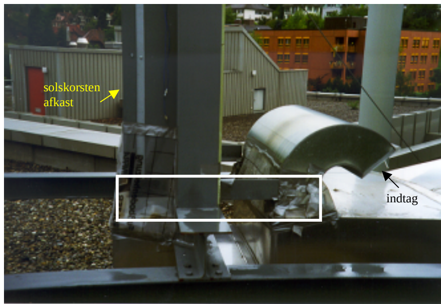
Figur 1.8. Udsnit af tag-unit. En vandret række heatpipes kan placeres mellem solskorsten (til venstre) og indtag (til højre) som vist med den hvide boks.
