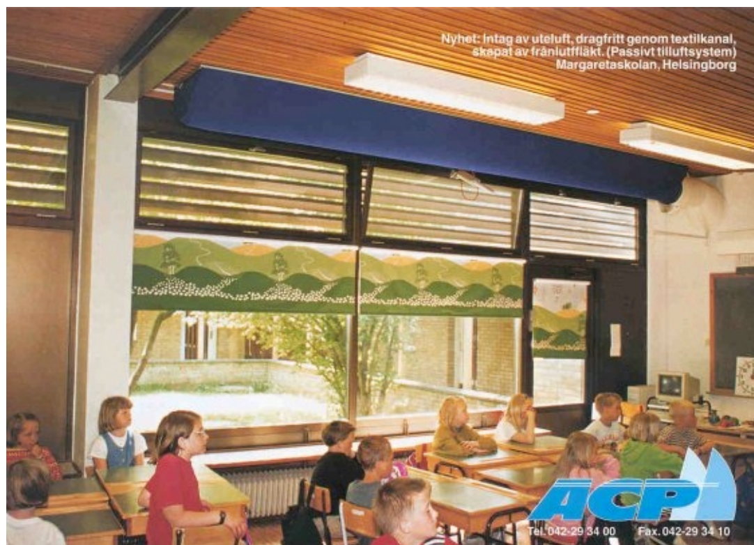
Figur 4.5: Direkte indtag af frisk luft gennem tekstilkanaler på Margeretaskolen i Helsingborg i Sverige. Kilde: KE-Fibertec /11/.
