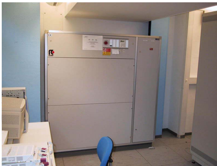
Figur 4.24. Billede af ”downflowunit” med vandkreds og frikøling hos CFI
