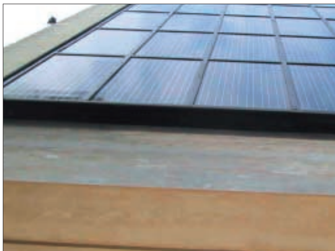
Figur 3. Indløbet til luftspalten bag PV-panejerne.
