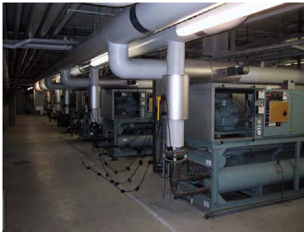
Figur 3. Køleanlægget der servicerer serverrummene og ca. 40 teknikrum samt levere noget komfortkøling.
