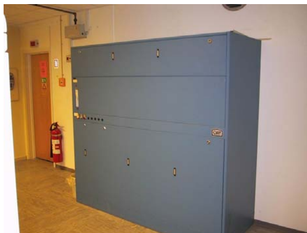
Figur 4. En af varmevekslerne (fan coil) i serverrummene.
