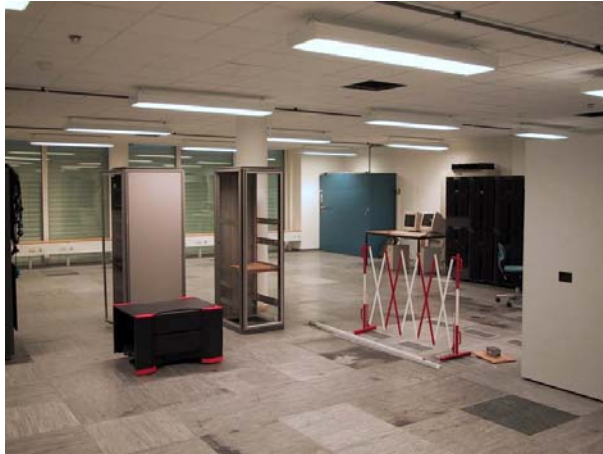
Figur 1. Serverrum i stueplan
