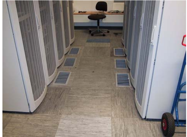
Figur 2. Riste i gulvet til indblæsning af kølig luft
