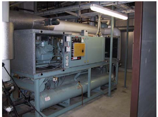
Figur 3. Køleanlægget der servicerer serverrummene og ca. 40 teknikrum samt levere noget komfortkøling.
