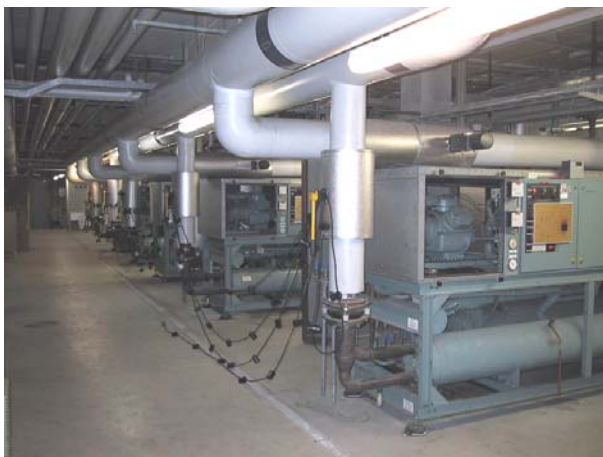
Figur 1: De fem Carrier køleanlæg
