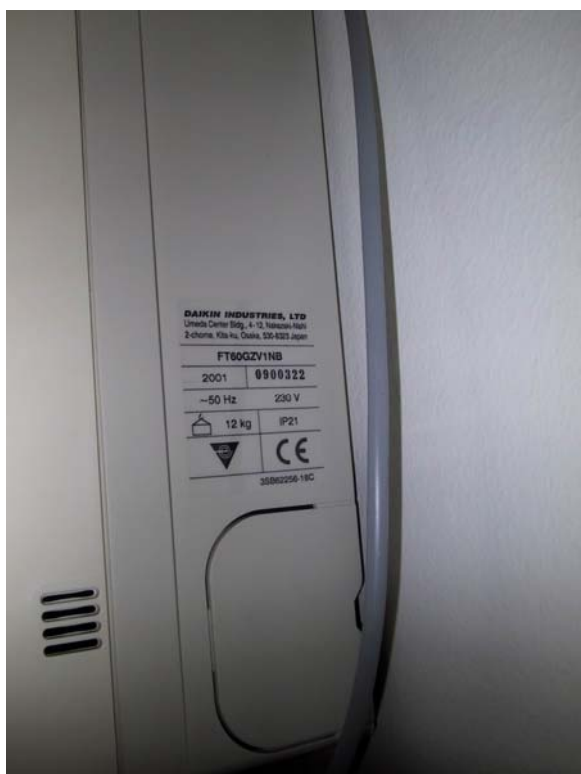
Figur 1: Køleanlæg - mærkeplade indedel og udedel.
