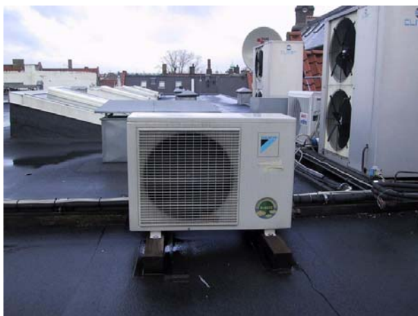
Figur 3. Køleanlæggets kondensator placeret på taget.
