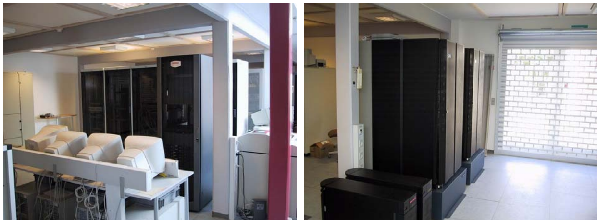
Figur 5. Reoler og rack i serverrummet. Den vestvendte glasdør er desuden vist i billedet til højre.
