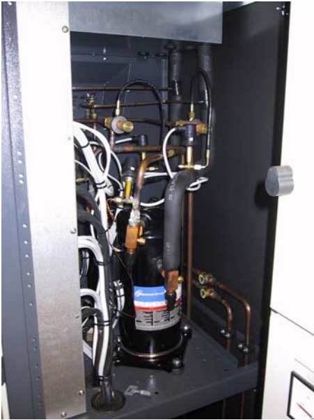
Figur 1: Et kig ind i kompressorrummet i det ene af de nye anlæg
