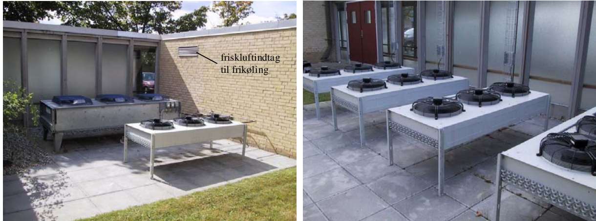
Figur 4. Køleanlæggets kondensatorer placeret udenfor. Til venstre det gamle anlægs kondensatorer og til højre de nye anlægs kondensatorer.
