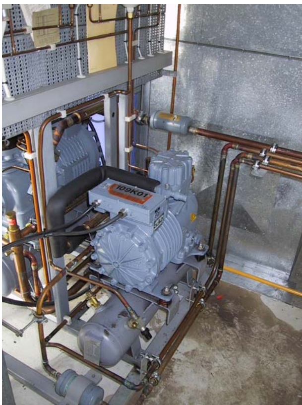
Figur 5: De to kompressorer der udgør kernen i det "gamle" anlæg.
