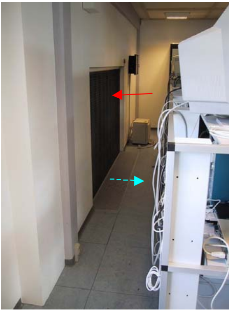
Figur 4: Indsugning og udblæsning fra gammelt køleanlæg
