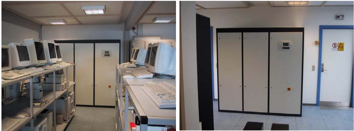
Figur 2. Serverrummets fordampere – til venstre også nogle af de gamle servere.
