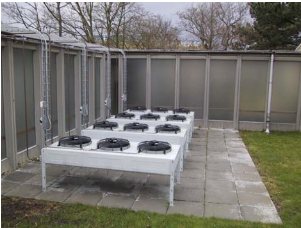
Figur 3: De to nye anlægs 4 kondensatorer, én pr. kompressor
