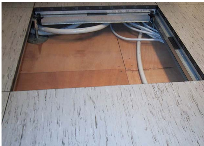
Figur 4: Billede af gulvkonstruktion hos Rigsrevisionen
