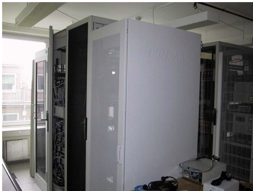
Figur 4. Rack'ne samt det ene vindue i serverrummet.
