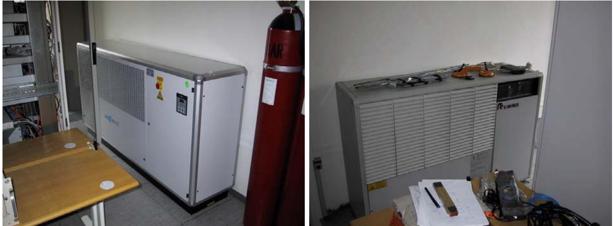
Figur 2. Serverrummets fordampere. Det nye anlæg til venstre og det gamle til højre.
