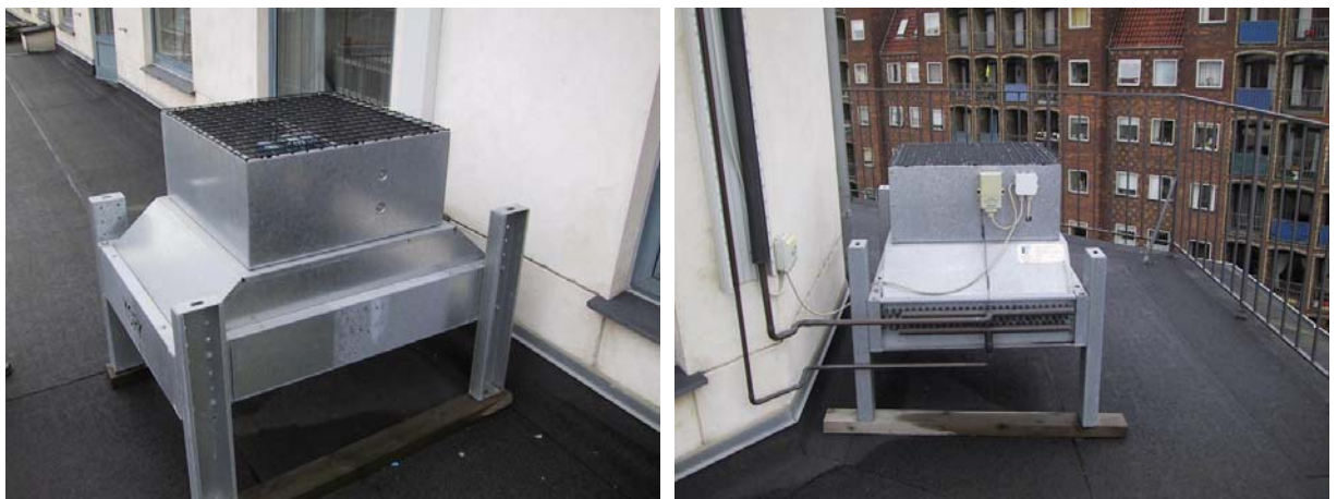
Figur 3. Køleanlæggets kondensatorer placeret på taget. Det nye anlæg til venstre og det gamle til højre.
