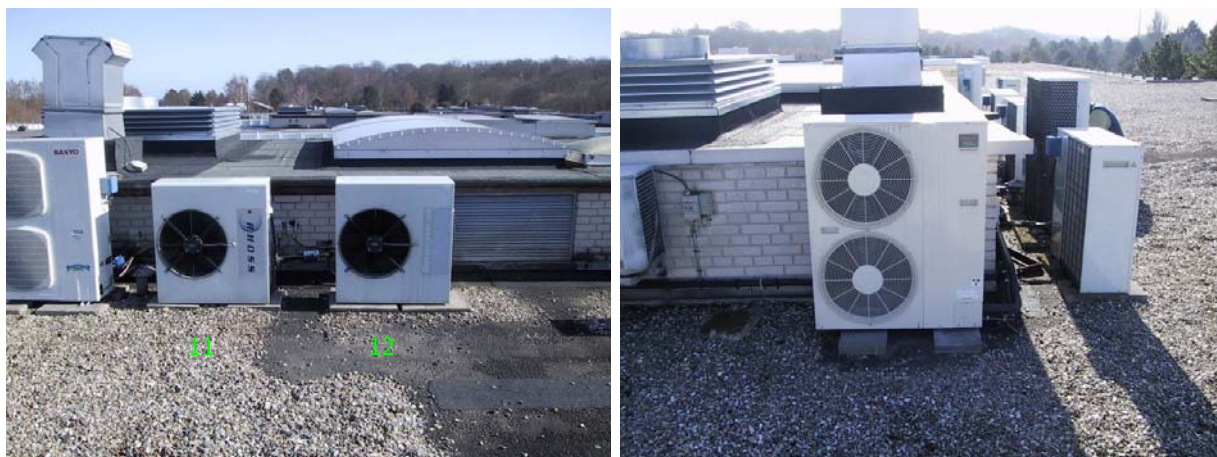
Figur 4. Køleanlæggets kondensatorer placeret på taget. Til venstre kondensatorerne til anlæg 11 og 12, til højre kondensatoren til anlæg 18.
