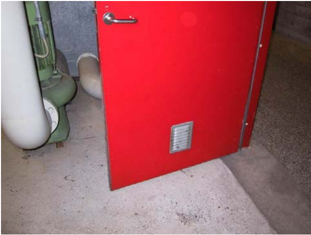
Figur 2: Billeder af rist for lufttilførsel til teknikrum, hvor anlæg 1 og 2's kondensatorer er placeret
