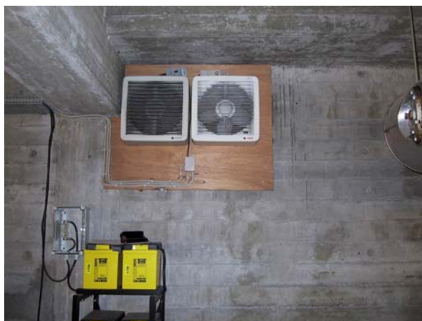
Figur 1: Køleanlæg - "udedel" til anlæg 1 og 2 er placeret i lille kælderrum med ventilatorer til aftræk
