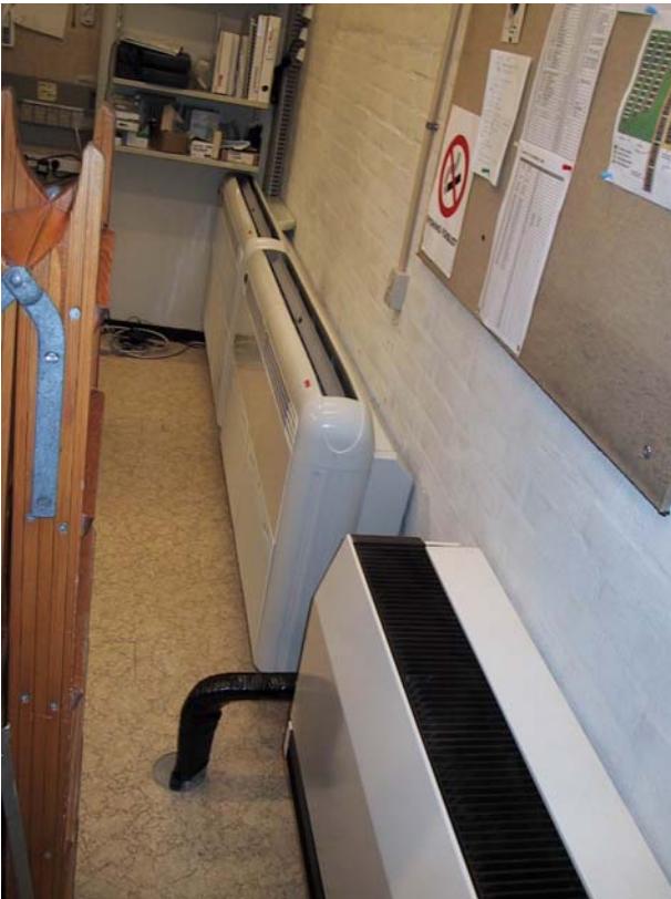
Figur 4: Billede de tre indedele i serverrummet (set fra oven anlæg 3, anlæg 1 og anlæg 2)
