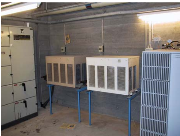
Figur 1: Køleanlæg - "udedel" til anlæg 1 og 2 er placeret i lille kælderrum med ventilatorer til aftræk
