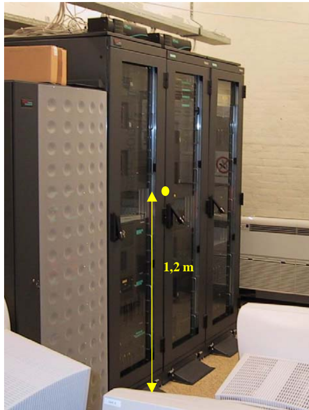
Figur 5. Placeringen af temperatursensoren ved måling af lufttemperaturen til serverne.
