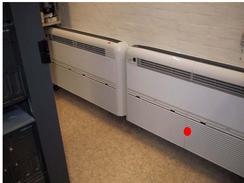
Figur 6. Placeringen af temperatursensoren for måling af lufttemperaturen til det ene køle-anlægs fordamper.
