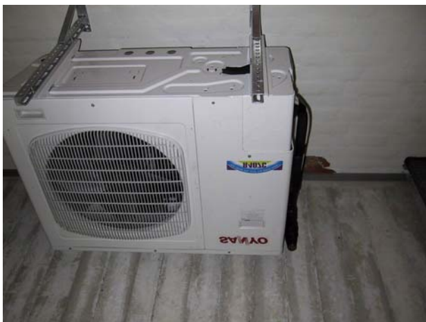
Figur 3: Billeder af anlæg 3's udedel placeret i cykelkælder
