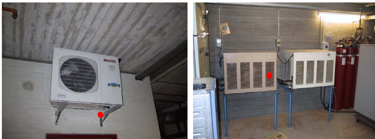
Figur 7. Placeringen af temperatursensorerne for måling af lufttemperaturen til køleanlæggenes kondensatorer – i cykelkælderen til højre og i teknikrummet til venstre.
