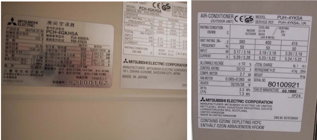
Figur 2: Stort anlæg - mærkeplade indedel og udedel.
