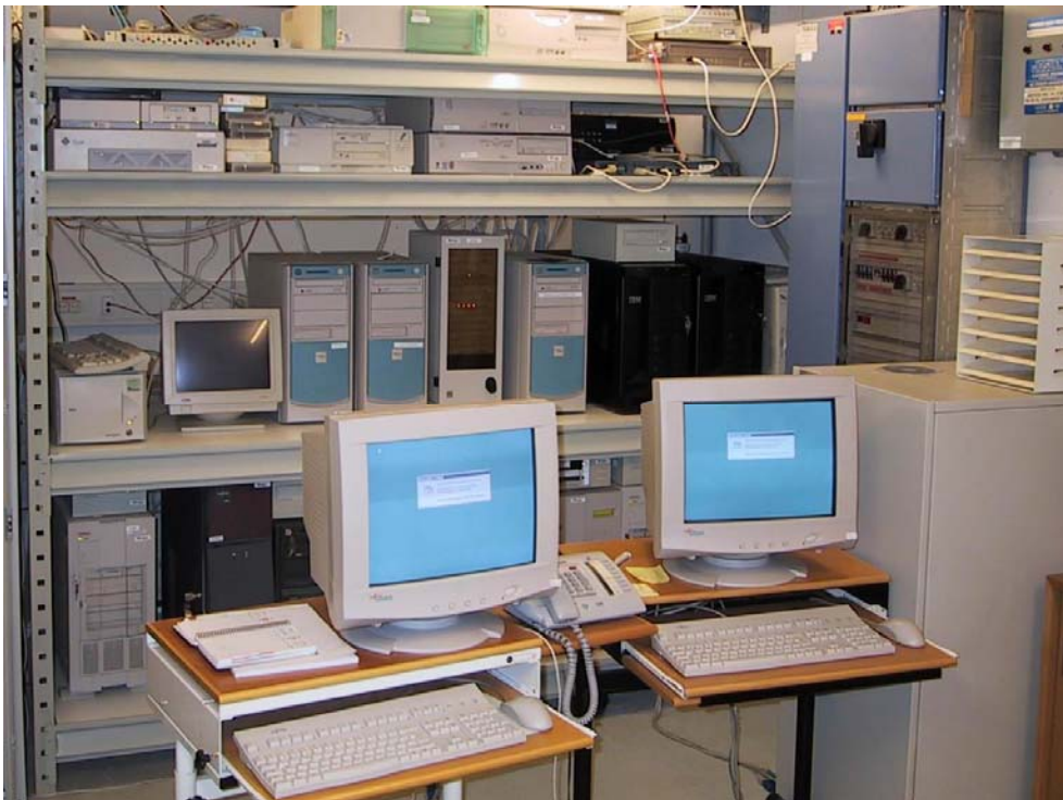
Figur 4: Placering af skærme direkte i kold luftstrøm mod servere.
