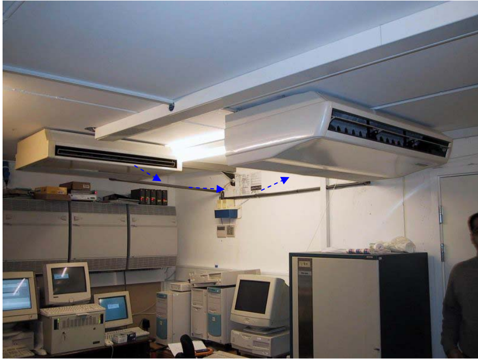
Figur 2. De to køleanlæg i serverrummet. Vedr. pilene – se senere.
